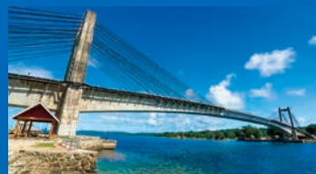
日本・パラオ友好の橋(パラオ)
